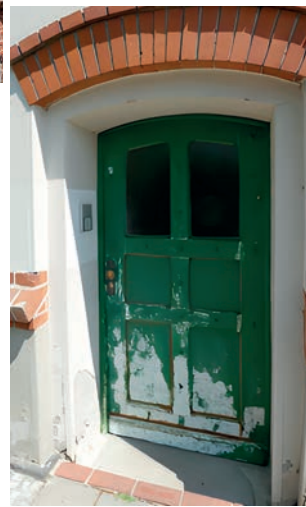
Am Jakobsgraben Tür während der Instandsetzung
