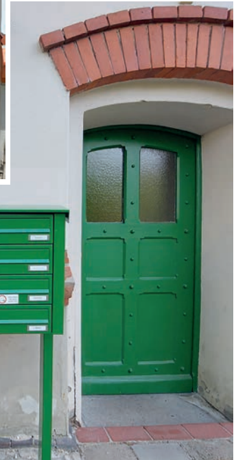
Am Jakobsgraben Briefkastenanlage und Tür nach der Instandsetzung
